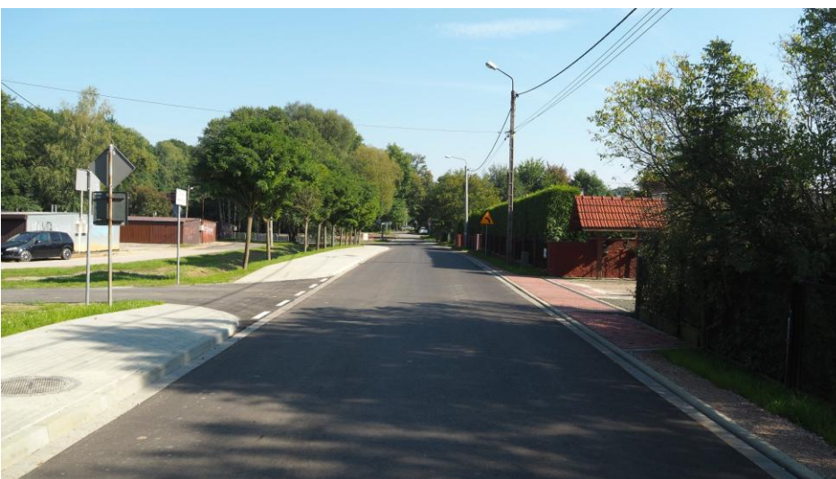
Zmodernizowana ulica Ofiar Faszyzmu w Chełmku.
