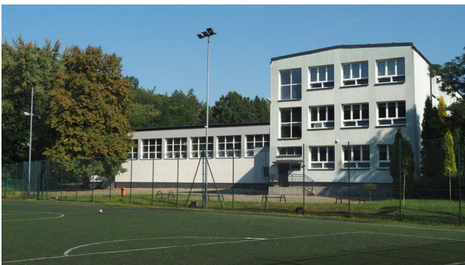
Zmodernizowany budynek Samorządowego Zespołu Szkolno – Przedszkolnego nr 2 przy ul. Piłsudskiego w Chełmku.
