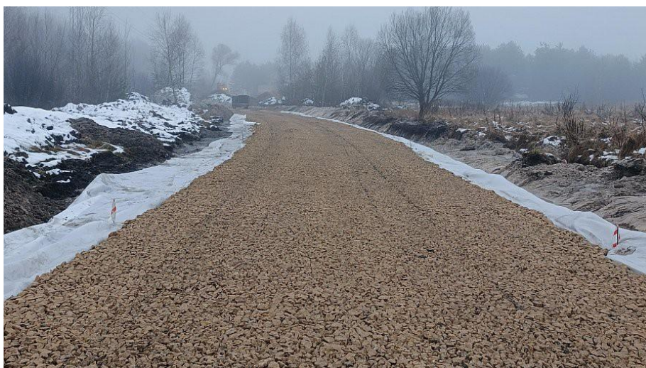
Budowa drogi gminnej łączącej ul. Poziomkową z ul. Tuwima.
