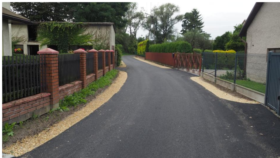
Zmodernizowana ulica Starowiejska w Bobrku.
