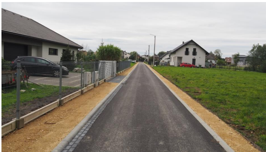
Zmodernizowana ulica Nowa w Bobrku.
